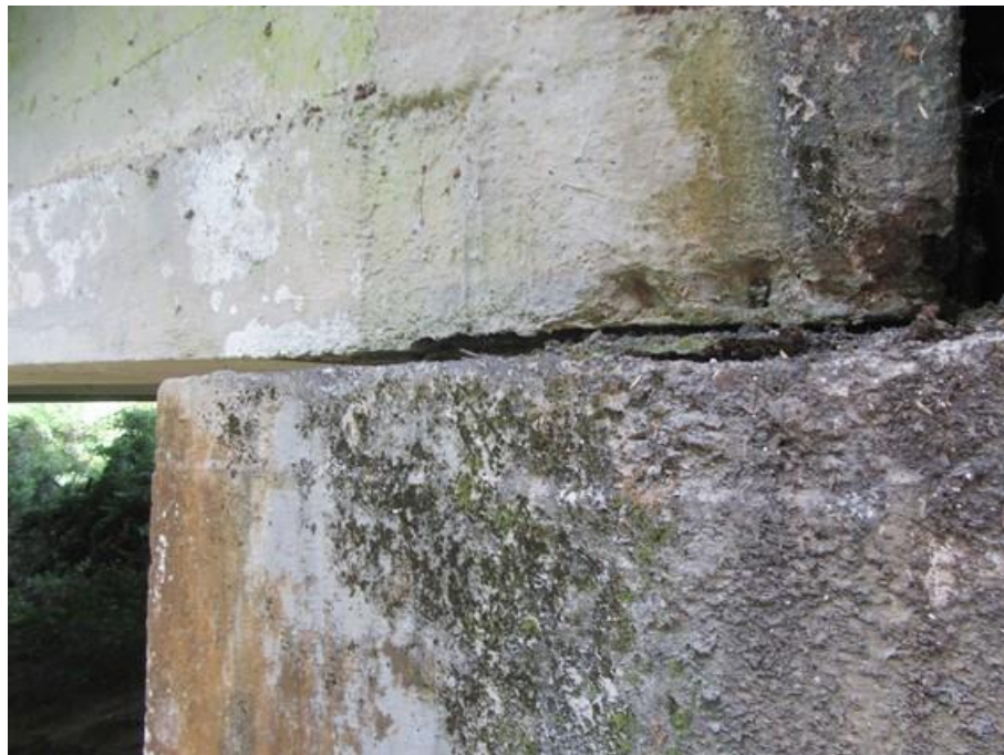
Foto 48 (IMG_1660) Viga longitudinal 1 – Apoio 1.
