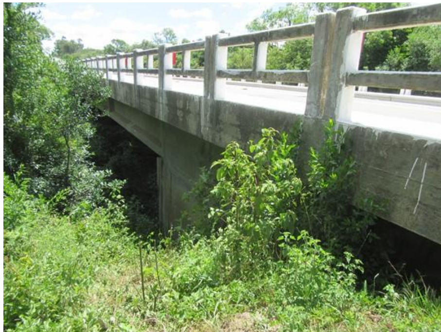
Foto 02 (IMG_1726): Vista lateral Oeste da OAE – Sul/Norte.
