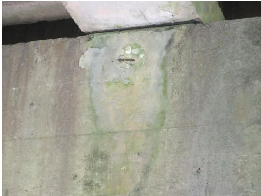
Foto 45 (IMG_1654) Viga travessa – Apoio 2 – face norte.
