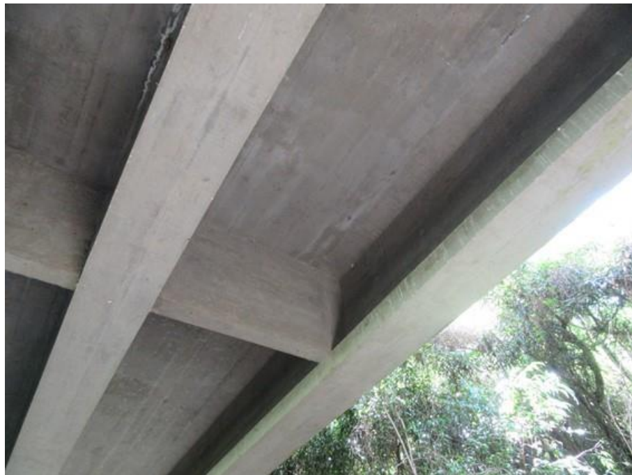
Foto 40 (IMG_1556) Vigas longarias 2 e 1.
