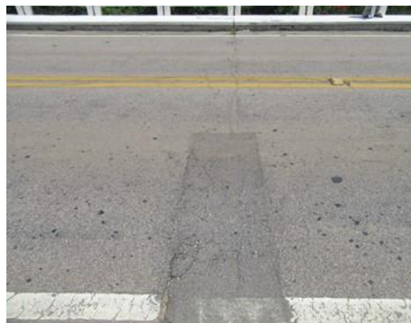
Foto 61: Junta de dilatação 2 - Vista Leste/Oeste.
