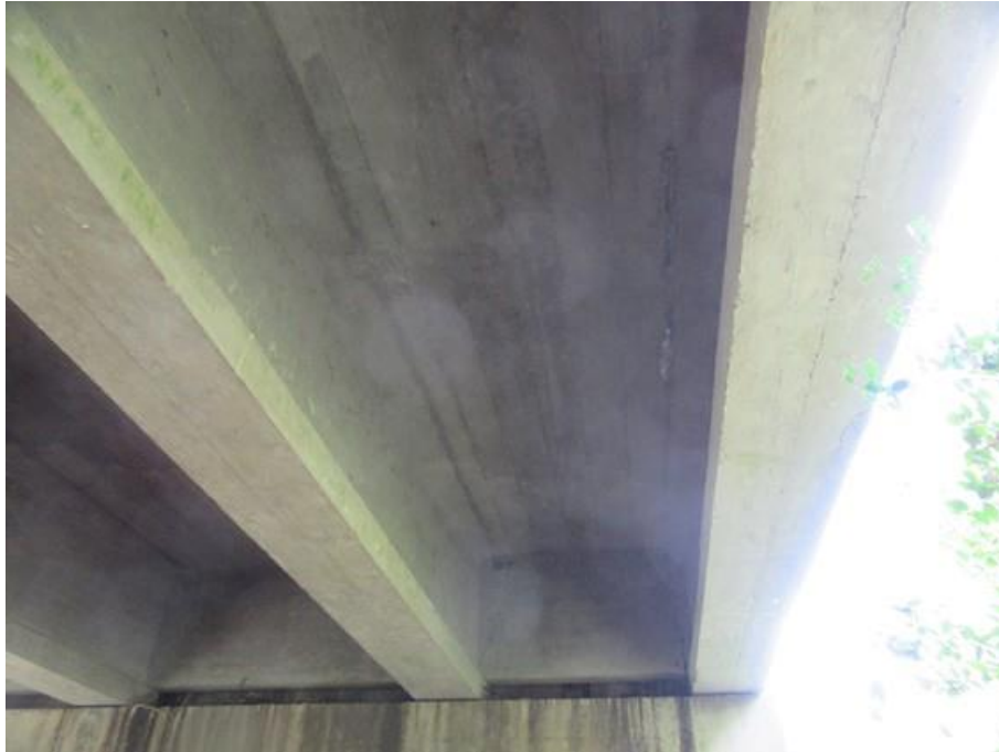
Foto 43 (IMG_1783) Vigas Longarinas 7 e 8 – Apoio 3.
