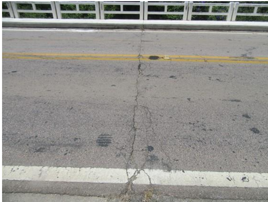
Foto 09 (IMG_1859): Junta de dilatação 1 – Vista Oeste/Leste.
