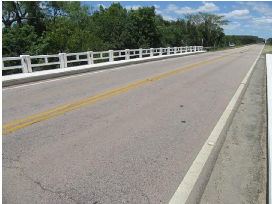
Foto 05 (IMG_1850): Pista Oeste – Vista Norte/Sul.
