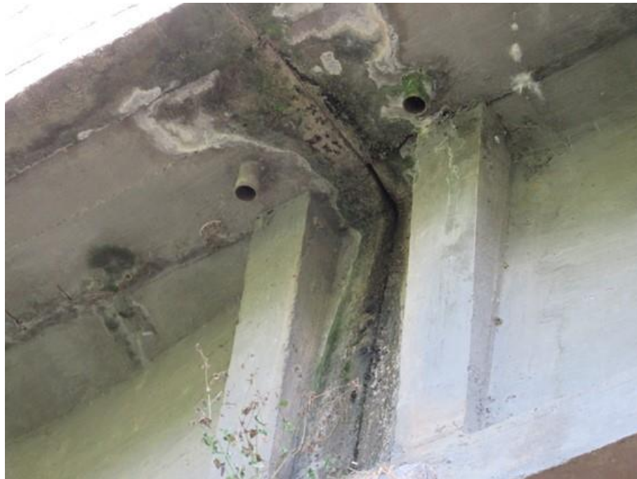
Foto 35 (IMG_1643): Balanço Leste – Junta de dilatação 2.
