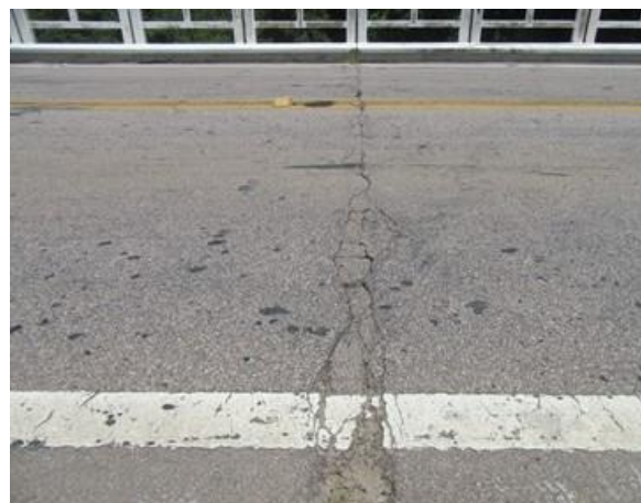
Foto 59: Junta de dilatação 1 - Vista Leste/Oeste.
