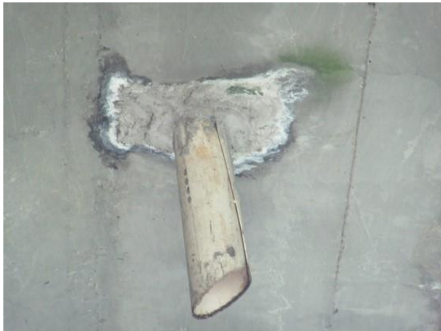
Foto 36 (IMG_1753): Buzinote – Balanço Leste.
