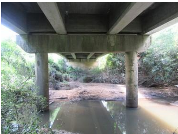
Foto 4: Apoio central – Vista Sul/Norte.
