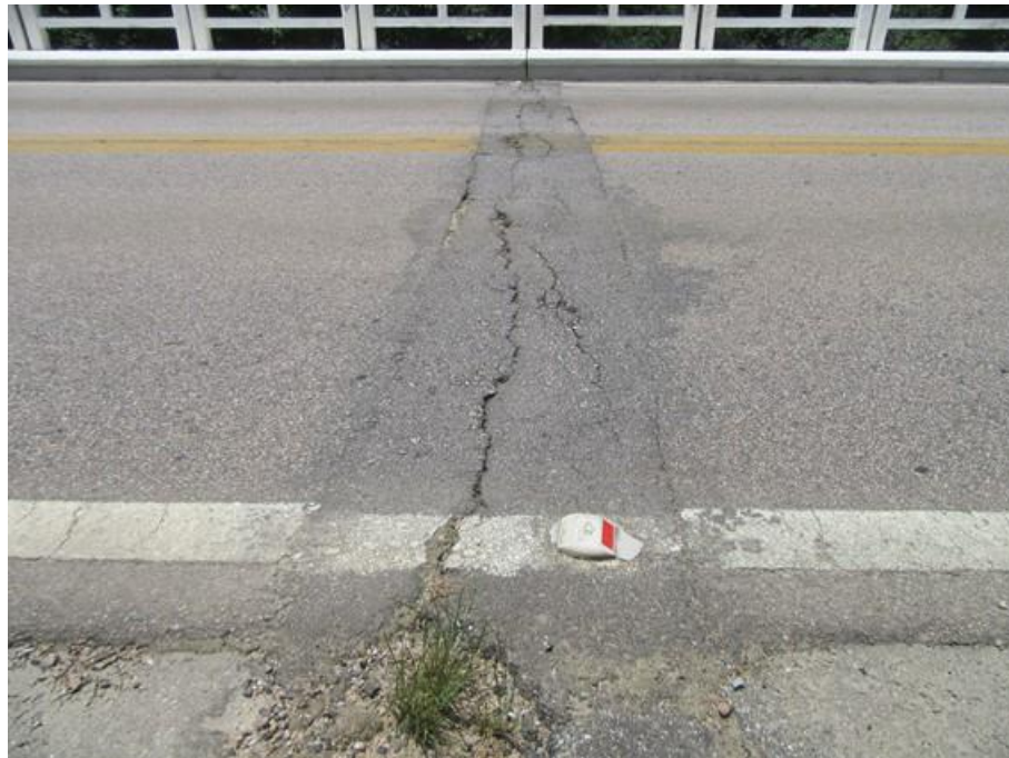
Foto 11 (IMG_1866): Junta de dilatação 3 – Vista Oeste/Leste.
