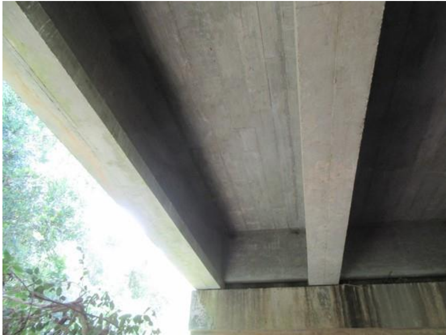
Foto 41 (IMG_1768) Vigas longarinas 5 e 6 – Apoio 3.
