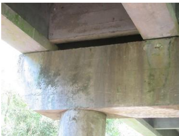
Foto 46: Apoio 2 - Face norte.
