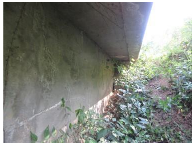
Foto 51: Talude lateral Leste – Encontro 1.
