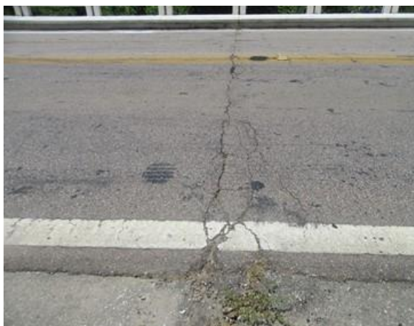
Foto 58: Junta de dilatação 1 - Vista Oeste/Leste.
