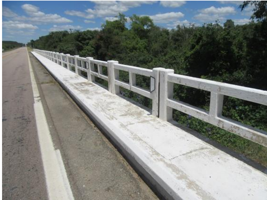
Foto 07 (IMG_1851): Guarda Corpo Oeste – Vista Norte/Sul.
