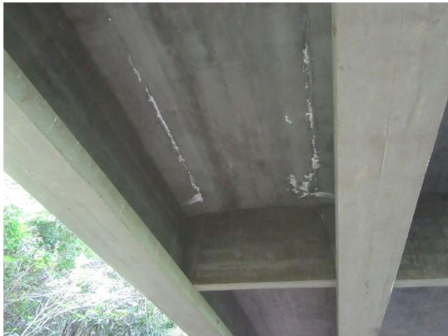
Foto 20 (IMG_1545): Laje – Face inferior entre VL1/VL2 e entre VT1 e VT2 – Vista Norte/Sul.
