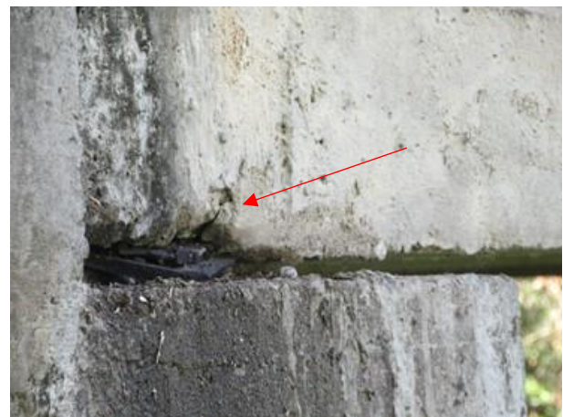
Foto 18: Viga longarina 4 – Apoio 1.
