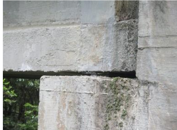
Foto 3: Aparelho de apoio do tipo elastomérico - Encontro.
