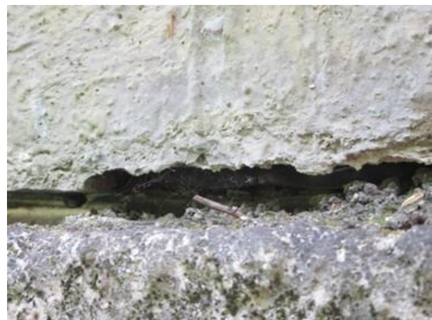
Foto 29: Detalhe: Encontro 1 – Aparelho de apoio VL1.
