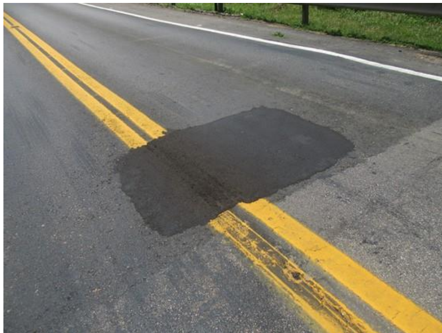
Foto 70 (IMG_1847) Aproximação norte.
