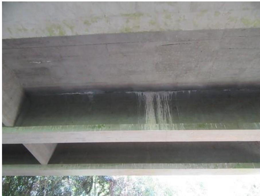
Foto 22 (IMG_1578): Viga Longarina 3 – face leste.
