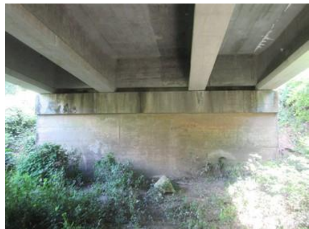
Foto 5: Encontro 1 – Vista Sul/Norte.
