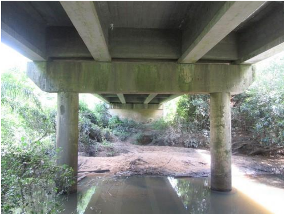
Foto 1: Sistema estrutural da ponte.
