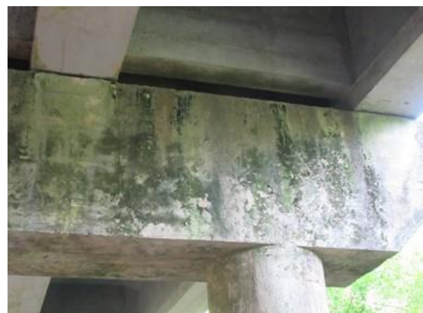
Foto 47: Apoio 2 - Face norte.
