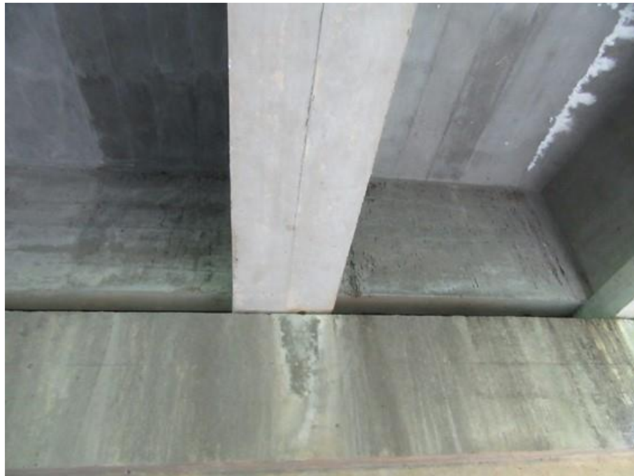
Foto 39 (IMG_1604) Viga longaria 2 e 1 – Apoio 1.
