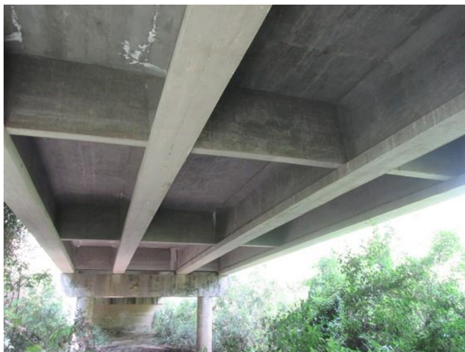
Foto 14 (IMG_1637): Tabuleiro – Vista Norte/Sul.
