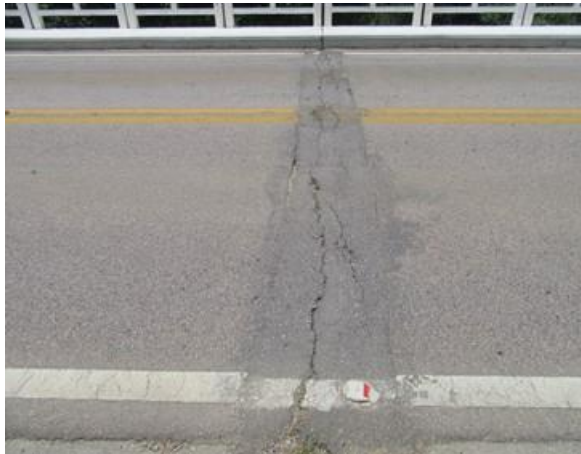
Foto 62: Junta de dilatação 3 - Vista Oeste/Leste.
