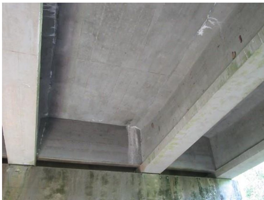
Foto 38 (IMG_1581) Vigas longarinas 2, 3 e 4 – Apoio 2.
