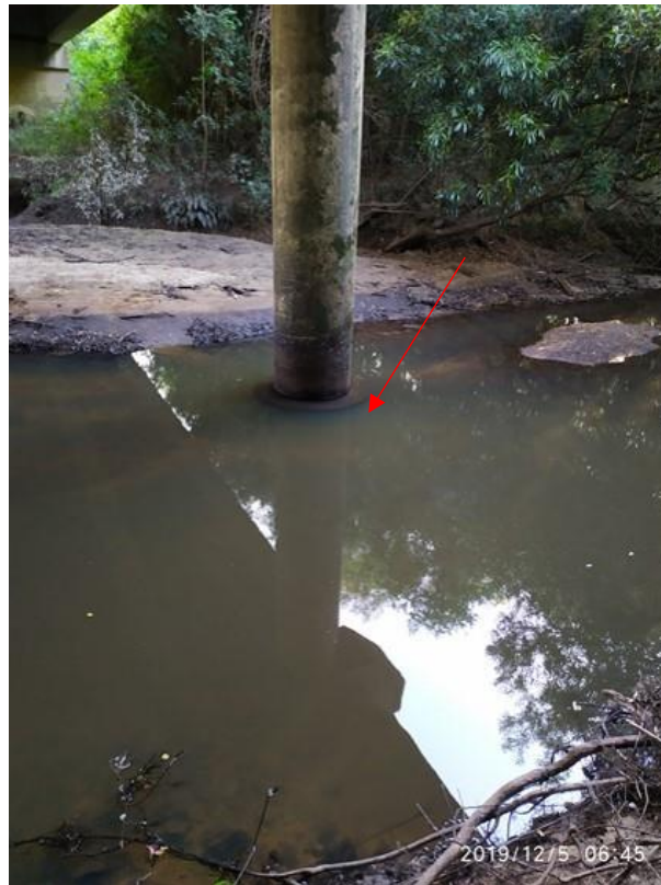
Foto 48: Tubulão - Apoio 2 leste.
