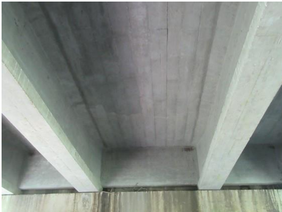
Foto 42 (IMG_1776) Vigas longarinas 6 e 7 – Apoio 3.
