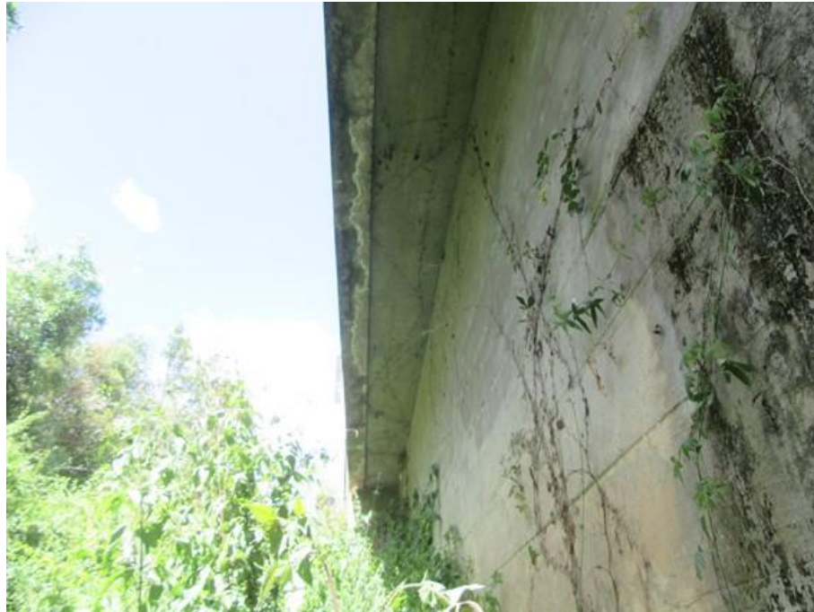
Foto 33 (IMG_1747): Balanço Leste – Vista Sul/Norte.
