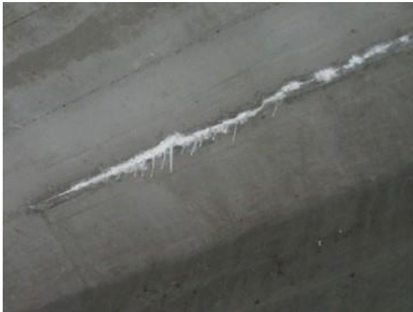
Foto 9: Laje entre VL 1 e VL2 – VT1 e VT2 – Formação de estalactite.
