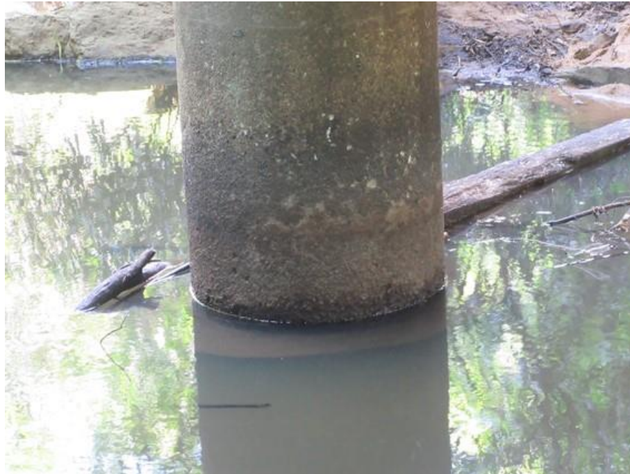
Foto 67 (IMG_1767) Apoio 2 – Pilar Oeste.
