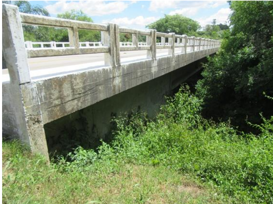
Foto 01 (IMG_1720): Vista lateral Leste da OAE – Sul/Norte.
