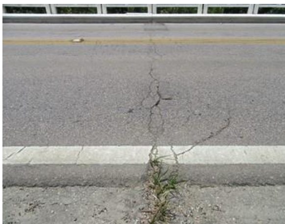
Foto 60: Junta de dilatação 2 - Vista Oeste/Leste.
