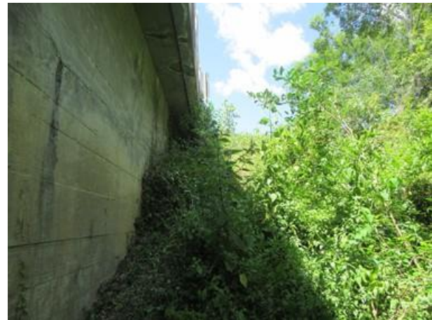
Foto 53: Talude lateral Oeste – Encontro 2.
