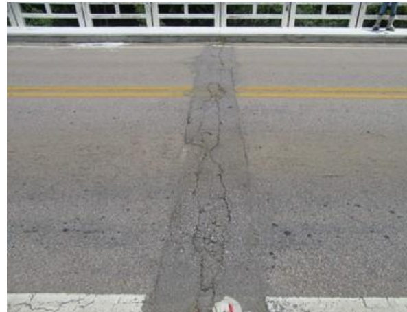
Foto 63: Junta de dilatação 3 - Vista Leste/Oeste.
