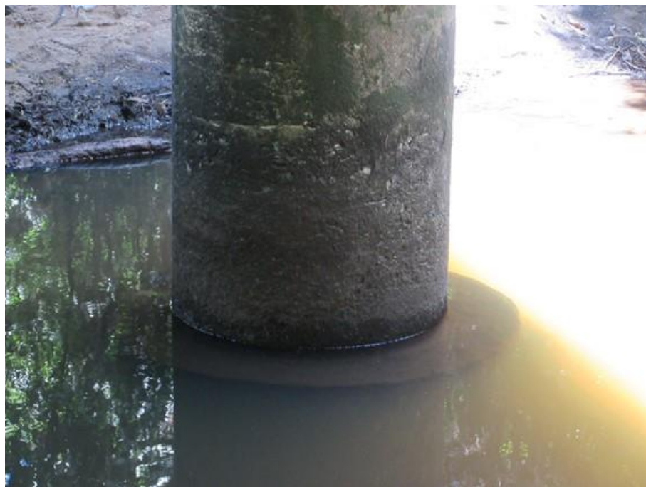
Foto 68 (IMG_1765) Apoio 2 – Pilar Leste.
