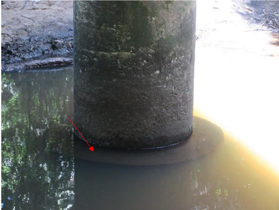
Foto 6: Tubulão – Apoio 2 - Pilar Leste.
