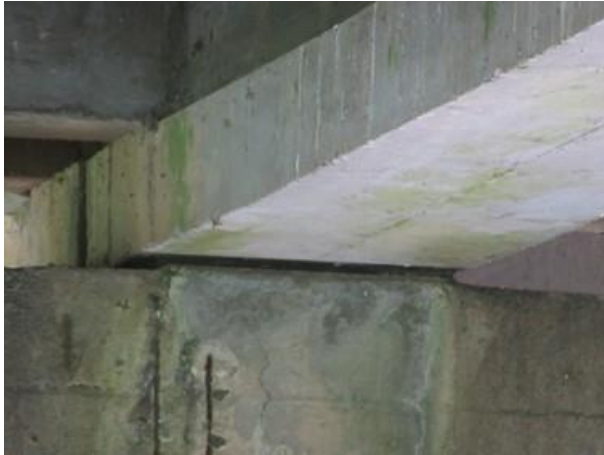
Foto 2: Aparelho de apoio do tipo elastomérico – Apoio central.
