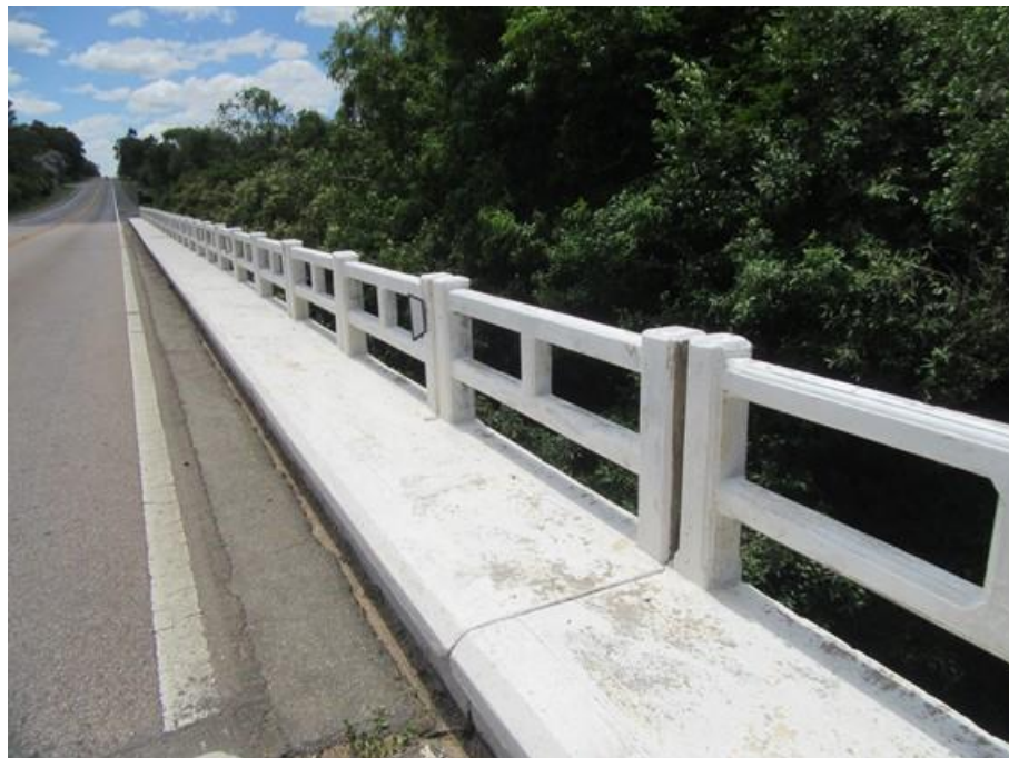
Foto 08 (IMG_1879): Guarda corpe leste – Vista Sul/Norte
