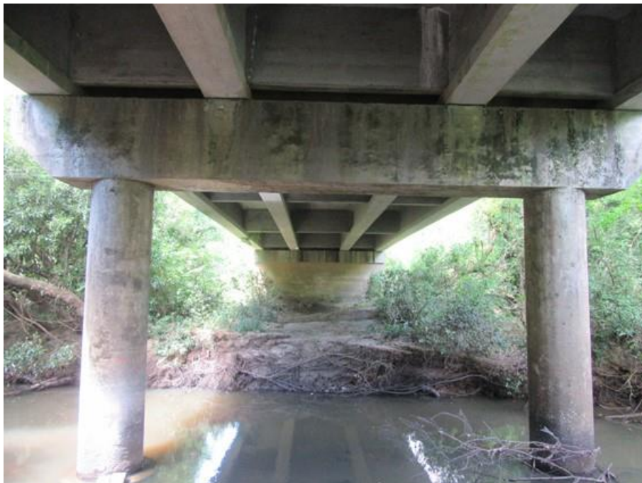
Foto 44 (IMG_1651) Apoio 2 – Face norte.
