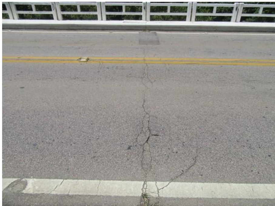
Foto 10 (IMG_1863): Junta de dilatação 2 – Vista Oeste/Leste.
