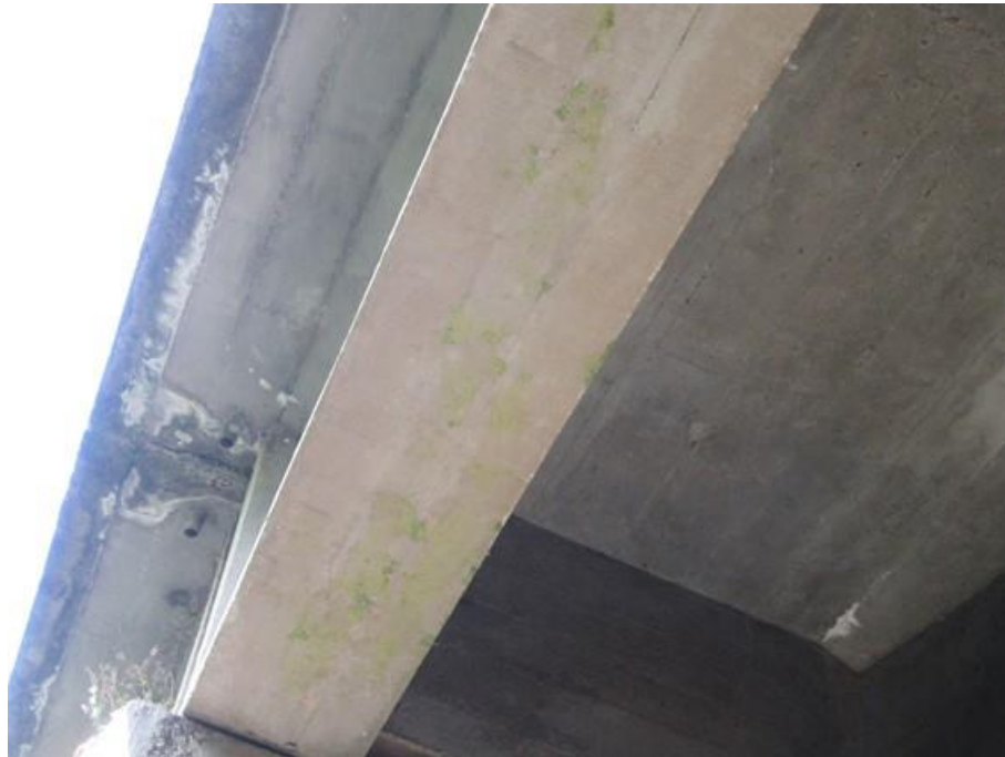
Foto 37 (IMG_1602) Viga longarina 1 – Balanço leste – Apoio 2.
