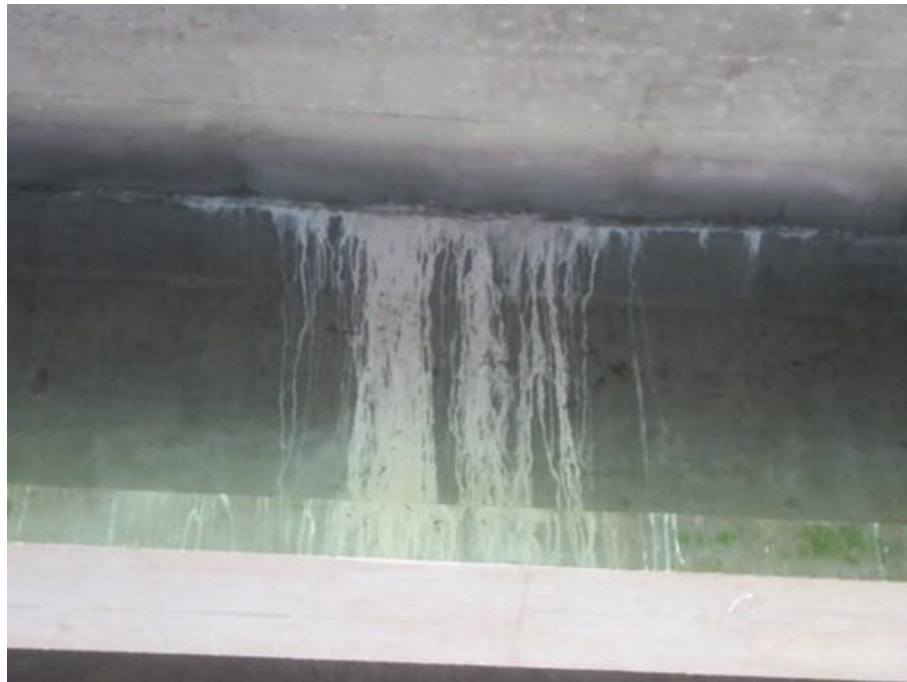
Foto 23 (IMG_1580): Viga Longarina 3 – face leste.
