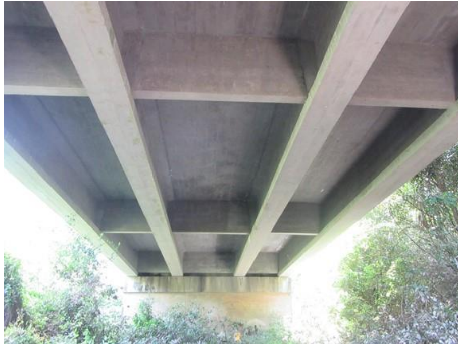
Foto 15 (IMG_1639): Tabuleiro – Vista Apoio 2/Apoio1.
