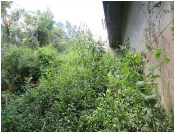
Foto 52: Talude lateral Leste – Encontro 2.
